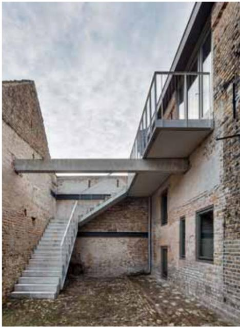
Die Außentreppe liegt auf einem neuen Betonträger auf, der von der Scheune zum Stall spannt
