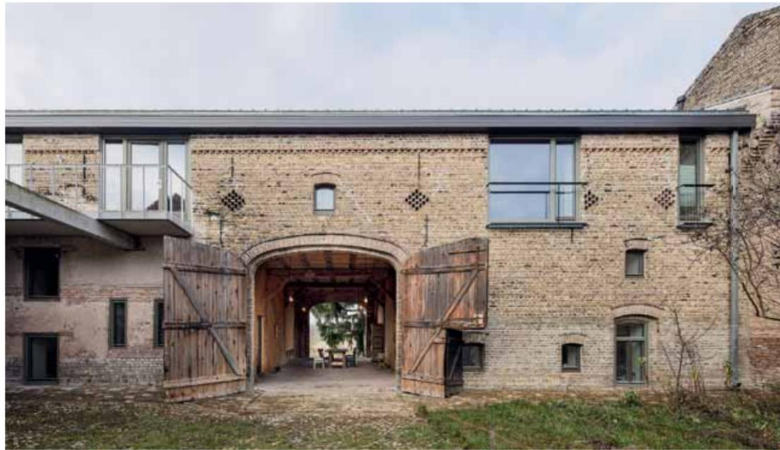
Fassade zum Hof: Alle Bestandsöffnungen wurden erhalten, neue Fenster sitzen bündig im Mauerwerk
